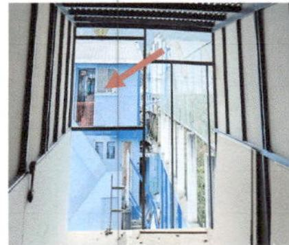
Sustitución de Estructura de Metal de ventana por PVC mas vidrios.
