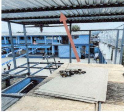
Sustitución de Lamina, por Lamina Troquelada Calibre 26 (incluye material de fijación).
