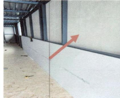
Sustitución de muro de Playwood por muro prefabricado acabo pintura.
